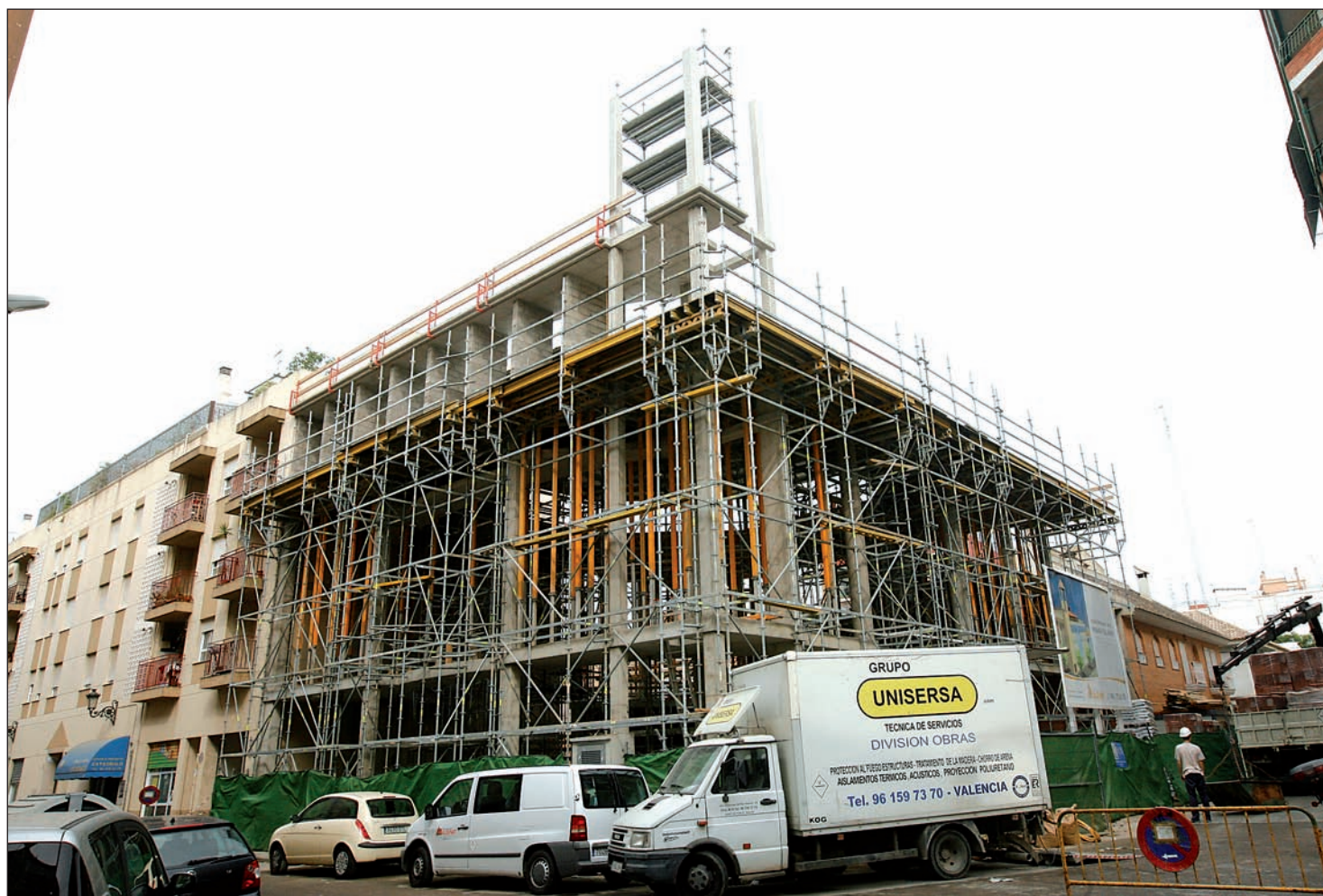
Construcción del templo de la Epifanía, en la Avenida de la Plata, número 69, de Valencia.
